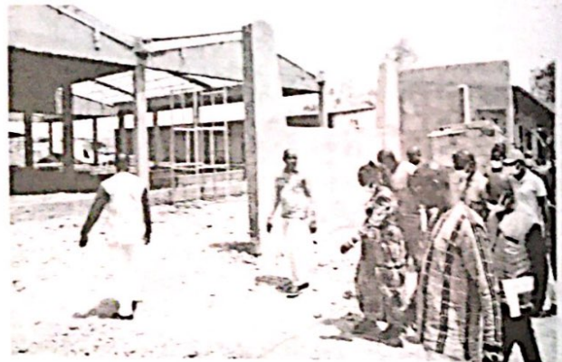
La délégation s'est dit satisfaite de l'évolution des travaux.
