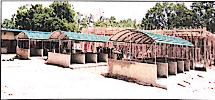
Le marché moderne de Arbolle comprend des boutiques, des magasins, un espace de boucherie, un espace d'étalage des produits et des toilettes
